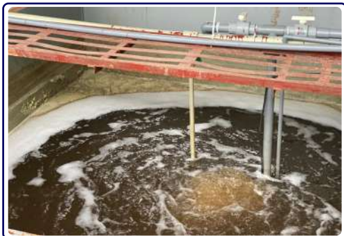
Bể oxy hóa khử màu nước thải
